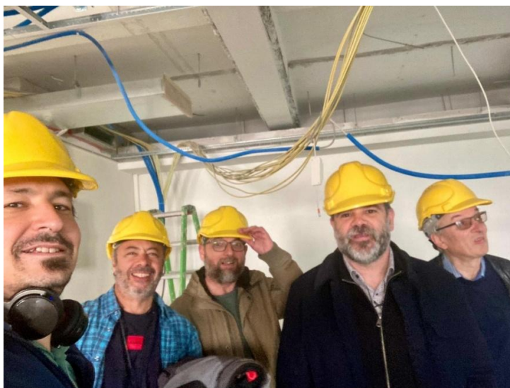
Visite du chantier de la Rue de Genève 88bis. © Cath-Info - FH
